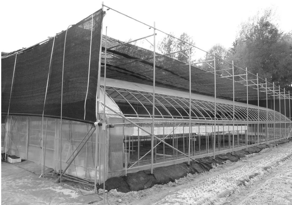
사진 6. 하우스 시설 측면(2012. 4)
