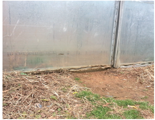
[그림 8] 출입문 하단과 지면 틈새 이격 연중 재배 시설이나 문 하부 틈새 이격에 대한 보완이 필요함
