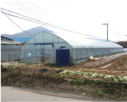
[그림 3] 고추 비가림 시설 지원 농가 밭에 설치될 경우 경지정리가 되지 않아 하부틈새 이격이 큼
