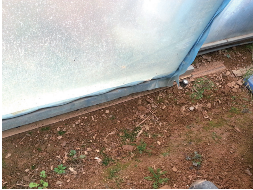
[그림 40, 41] 하부 가이드 롤러 문짝의 궤도이탈 방지 및 강풍 시 문을 고정해줌
