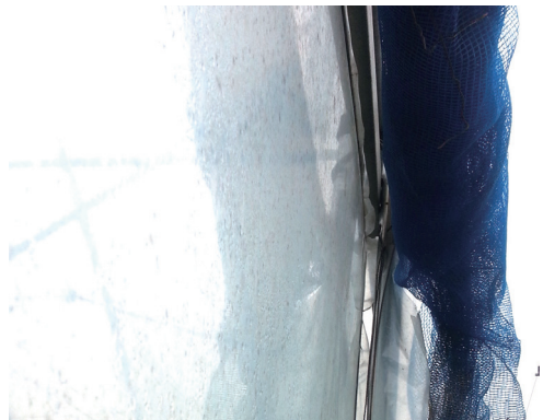
[그림 6] 레일과 문짝이 이격되어 틈 발생 연중재배를 위한 시설 활용 시 문틀과 문짝의 틈새 이격에 대한 보완 대책이 강구되어야 함
