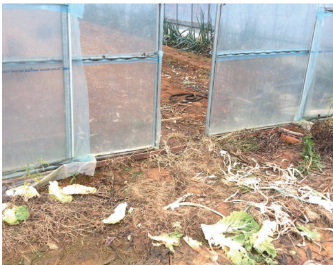
[그림 5] 출입문 하부 움직임 방지 레일 설치 연중 재배를 위한 시설 활용 시 하부 레일 틈새 이격 보완이 필요한 시설임
