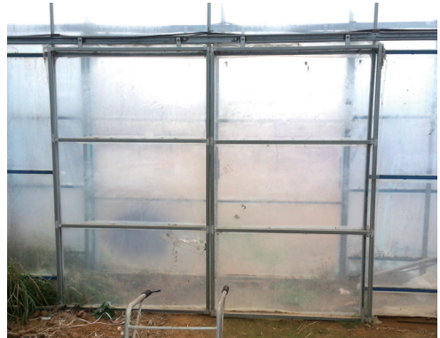
[그림 10] 중간지점이 없어 좌우 틈새 확대 문짝과 문틀의 크기가 달라 단부에서 틈새가 크게 형성됨
