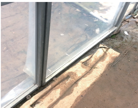
[그림 17] 외풍 대비 문턱 하부 말뚝 설치
