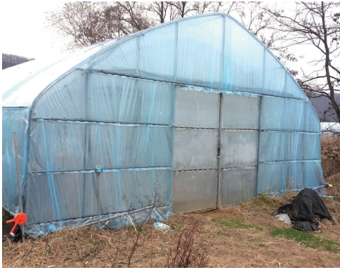
[그림 7] 비닐 교체 시 출입문 제외 인건비 절약을 위해 기존 비닐을 존치, 출입문 비닐 교체가 이루어지지 않음
