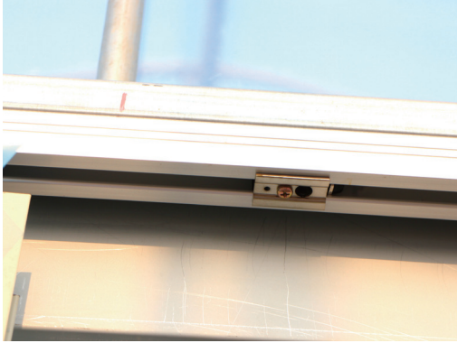
[그림 34] 상부 레일 스토퍼 설치 문짝이 닫히는 위치를 정함
