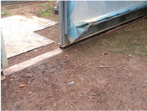
[그림 42] 하부 개스킷 설치 하부 각파이프 및 개스킷 설치를 통하여 이동통로의 요철 문제를 해결하고 기밀 성을 도모함
