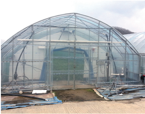
[그림 13] 하부공간이 매우 작게 설치됨 하부 틈새 이격은 작으나 하부 보강재 미설치
