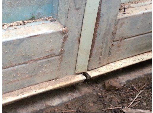
[그림 37] 하부 개스킷 설치+요철 결합 요철형 결합으로 틈새 이격 최소화 및 기밀성을 도모함
