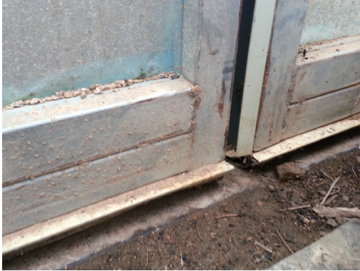
[그림 36] 하부 개스킷 설치+요철 결합 전 요철 결합 제작으로 문닫힘을 더욱 견고 하게 함
