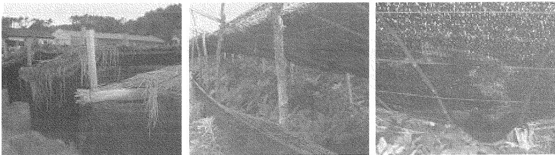
그림 2. 전후주연결식 구조(좌로부터 각목, 통나무 기둥, 대나무 보조연목)
