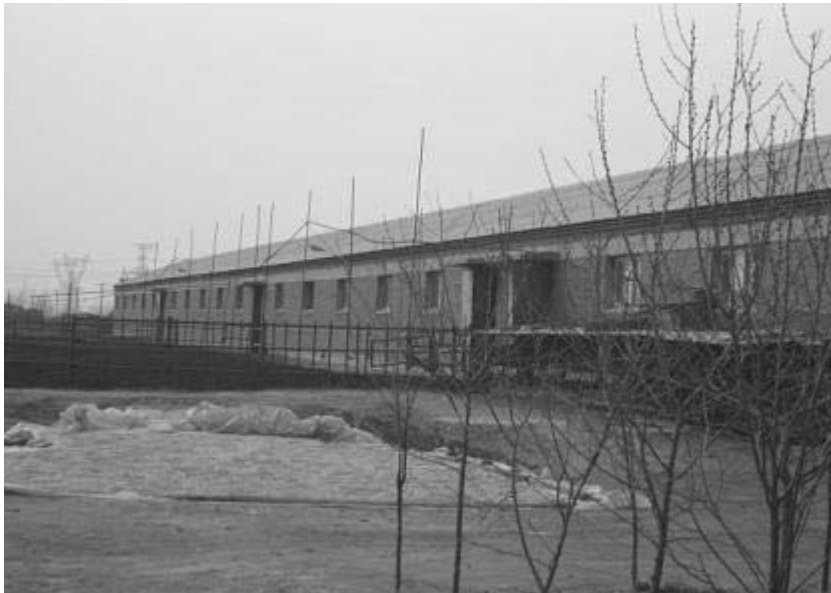
〈사진 2〉 낙농농장 전경
